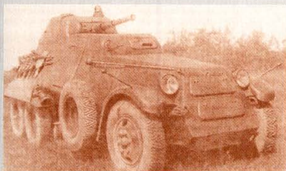
На этих фотографиях хорошо заметны гусеничные цепи «Оверолл», закрепленные на корпусе броневомобиля БА-11.
