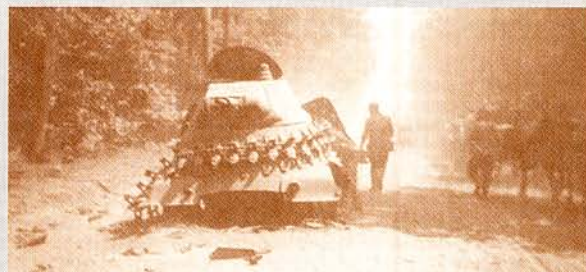
На этих фотографиях хорошо заметны гусеничные цепи «Оверолл», закрепленные на корпусе броневомобиля БА-11.
