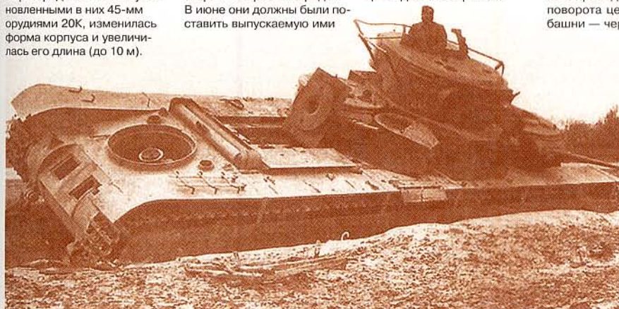
Гусеница мелкозвенчатая, траки с открытым шарниром. Опорные катки обрешеченные, поддерживающие катки с резиновыми шинами.
